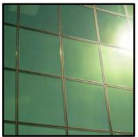
LIGHT GREEN TINTED GLAZING TO TOWER COMMERCIAL LEVELS **BEHIND SUN SHADING SCREEN**
